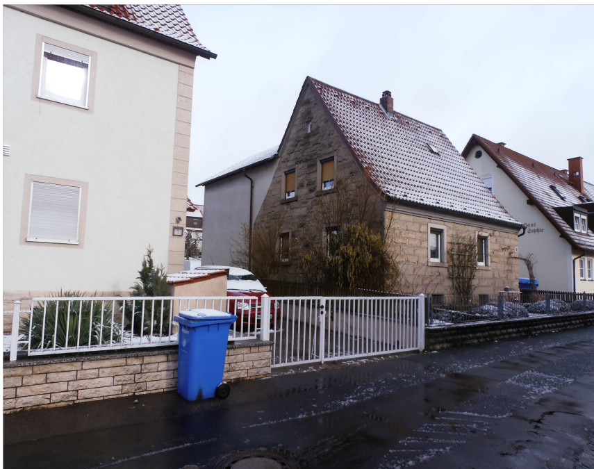
Zweigeschossiges Wohngebäude (mit dem zweiten Vollgeschoss im Dachgeschoss) mit bestehendem Anbau
